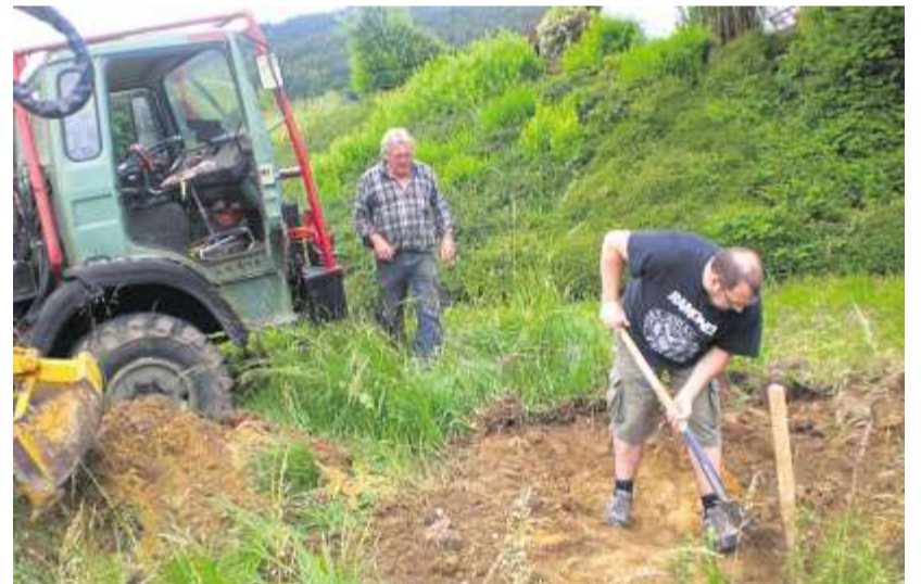
Spatenstich: Stephan Späth mit Schwiegervater Otto Frisch
