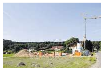
Schließlich kommen die Steine fürs Mauerwerk. Die Maurer beginnen.
