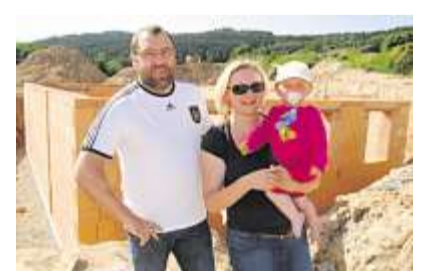
Die Familie ist zufrieden: Der Keller steht, die Decke kann kommen.
