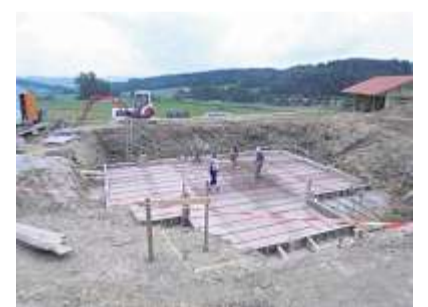
Die Bodenplatte folgt dem Loch.
