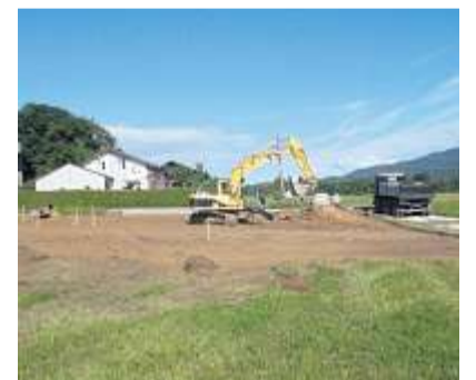
Der Bagger ist da, das Loch folgt.
