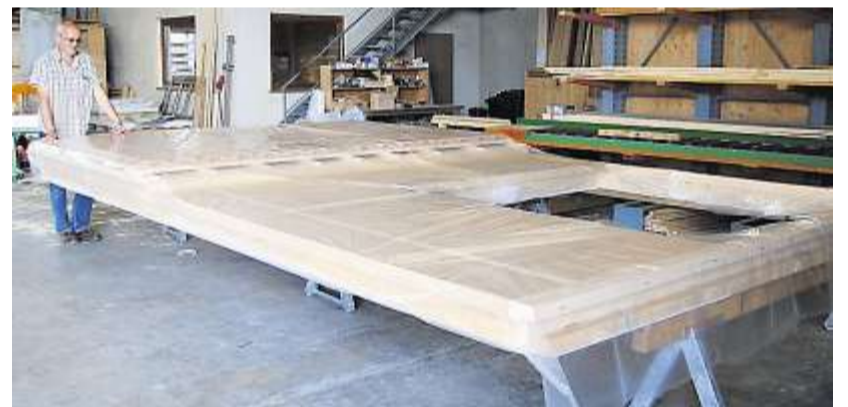
Eingepackt wartet ein Stück vom Späth-Haus auf den Zeitpunkt des Aufstellens. Teredo-Geschäftsführer Josef Karl begutachtet die Arbeit.
