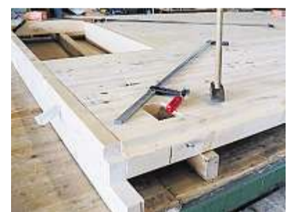
Das bedeutet Vollholz: Brettstapel sind gedübelt, sie halten ohne Leim.
