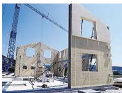
Schließlich stehen drei Außenwände.
