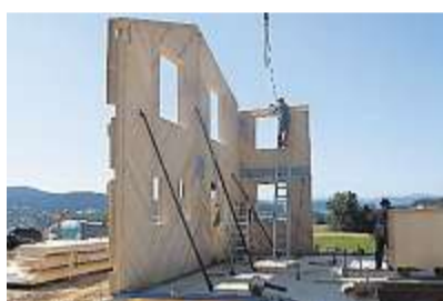
Die erste Außenwand sitzt.
