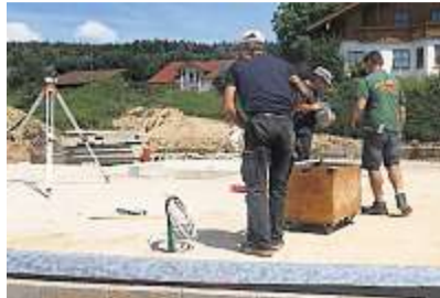
Die Baustelle wird vorbereitet.
