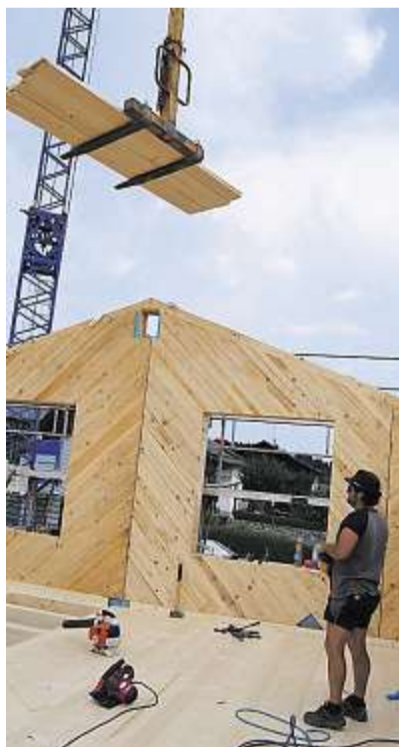
Nach zwei Tagen beginnt der Innenausbau des Hauses.
