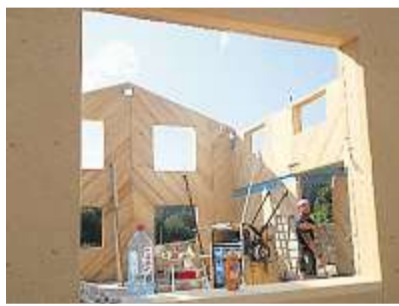
Einblick: Alle Wände stehen.
