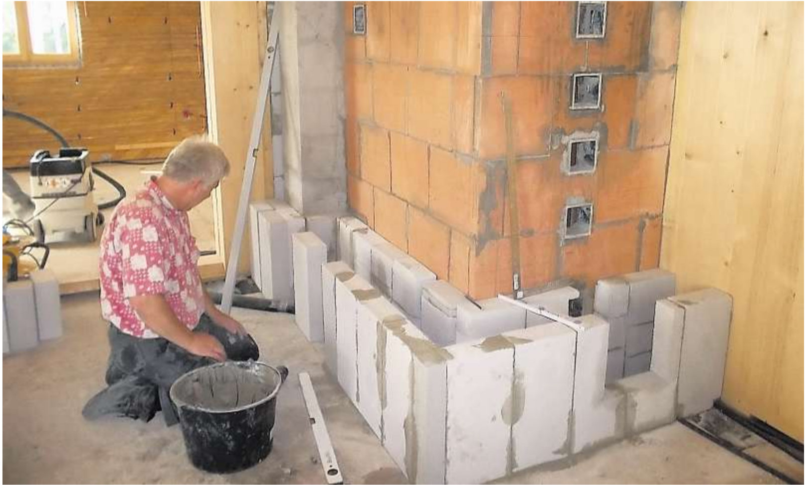
Kachelofenbauer Andreas Vogler bei der Arbeit am Herz des Holzhauses, dem Grundofen. Dieser Tage soll er erstmals angeschürt werden.
