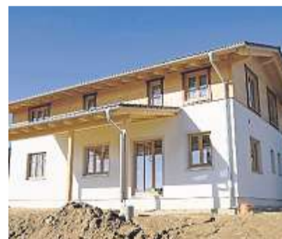
„Habt ihr doch noch in Stein gebaut?“ – mancher hat sich schon täuschen lassen, weil das Haus im unteren Teil verputzt worden ist.
