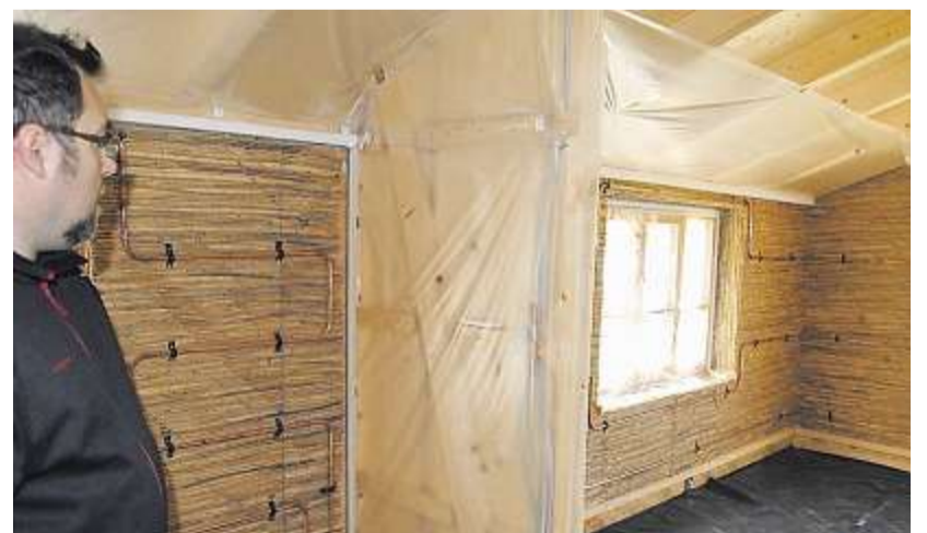
Auf den Schilfmatten sind die Kupferrohre angebracht, in denen das warme Wasser durch die Wände läuft. Bauherr Stephan Späth hat alles fotografiert, um zu wissen, wo welche Leitung verläuft. Fotos: ck/priv.
