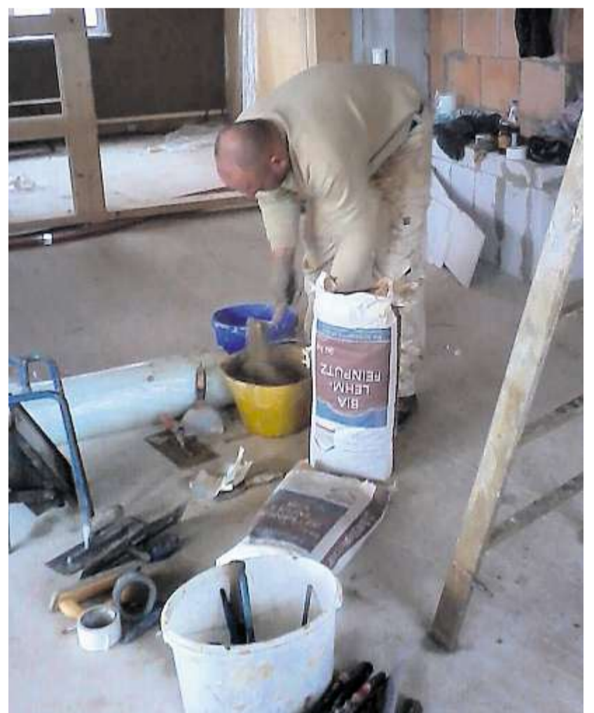
Viel Wasser mit viel Lehm gemischt ergibt die richtige Konsistenz für den Innenputz, der nach dem Trocknen richtig hart wird.
