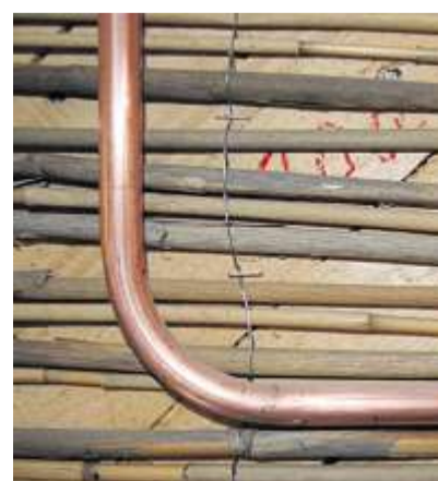
Der Lehm krallt sich in den Schilfmatten fest und deckt die Wandheizung zu.
